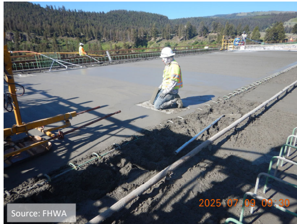
Deck Pour at the Finishing Phase.
