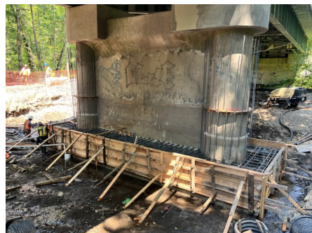
Pier 5 Footing Pour—Barnard
