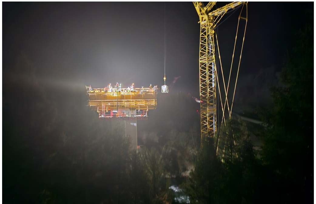
Night pour for Pier 3 End Cap
