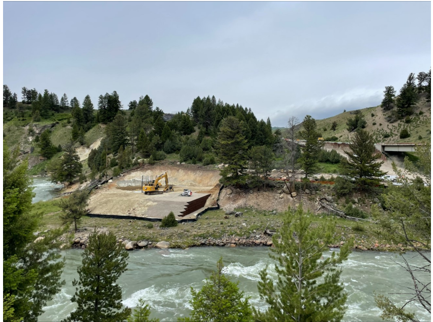
MSE Wall Pier 2
