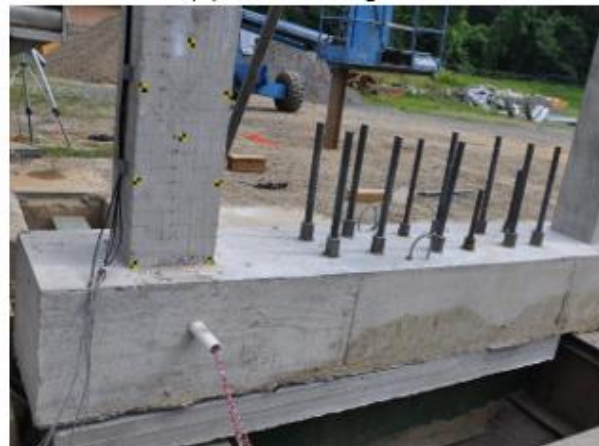
(d) Close view of the bolts connections.
